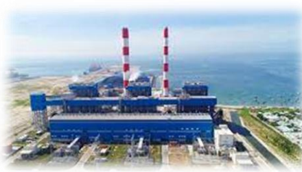
Nhà máy Nhiệt điện Vĩnh Tân 4: 05 sinh viên Điện CN
