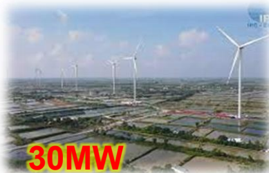
Nhà máy điện gió Phước Hữu – Duyên Hải 1: 01 sinh viên Điện CN
