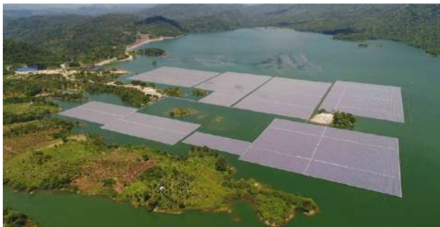
Ảnh 5. Điện mặt trời nổi tại tỉnh Lâm Đồng
