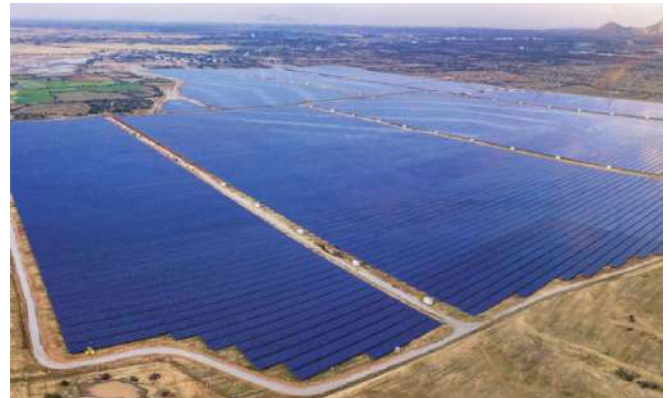
Ảnh 1. Một nhà máy điện mặt trời lớn ở tỉnh Ninh Thuận.
