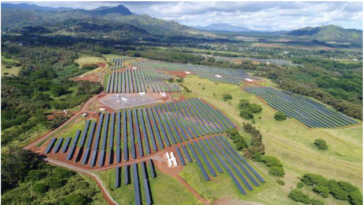
Ảnh 3. Nhà máy năng lượng mặt trời-kết hợp-pin lưu trữ ở Kauai, Hawaii.
